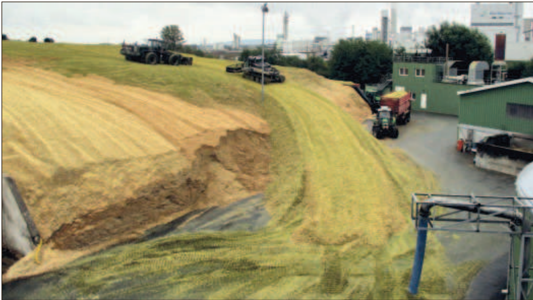
Wirkt imposant auf dem Gelände der Biogasanlage: der meterhohe Maissilage-Berg.
