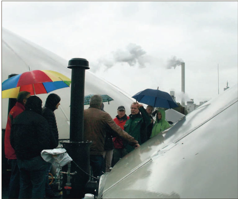
Auf dem Rundgang des Fermenters: Der Fermenter ist das Herzstück einer Biogasanlage. In ihm finden die Abbauprozesse der organischen Substanz statt, bei denen das Biogas entsteht.
